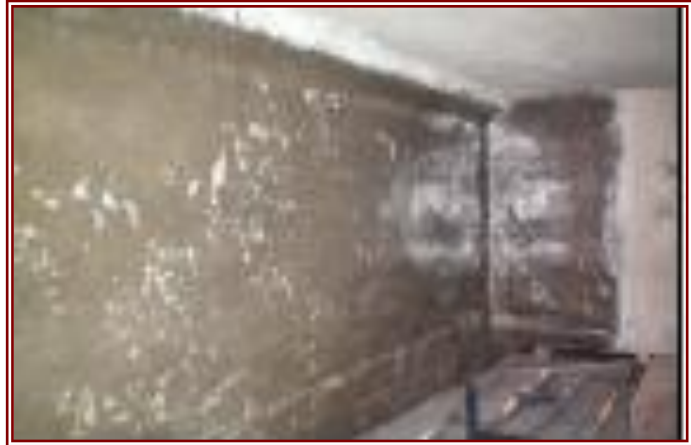
After Primer Coating
